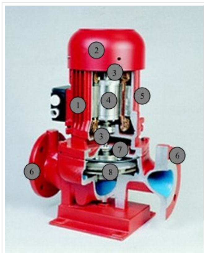
Устройство центробежного насоса Kolmeks
